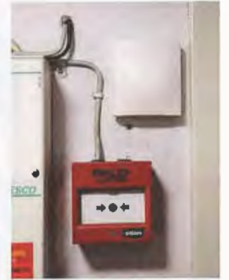
Oskelantie 4:n taloyhtiössä on laaja anturointi kosteus- ja lämpötilatiedon kokoamiseksi.
