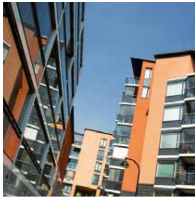
Anläggning som ska övervakas
