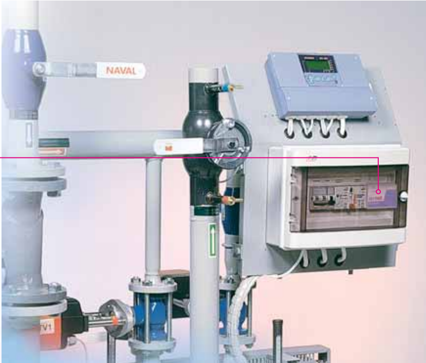
Paigaldatud EH-net-server. Väike ja kompaktnen server sobib paigaldamiseks DIN-siinile.
