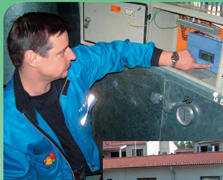
Регулятор вентиляции EH-105 легко и удобно использовать. Регулятор показывает историю сигналов тревог, часы использования и в ситуации тревоги подает звуковой сигнал. Добавить дополнительные сигналы тревоги и осуществить передачу последующих сигналов можно, например, с помощью мобильного телефона. Причина неисправности выводится понятным текстом на экран регулятора, эта информация важна для пользователя, как, например, в этом детском саду Кою в Эспоо (Саарнимяенкюя 8)
